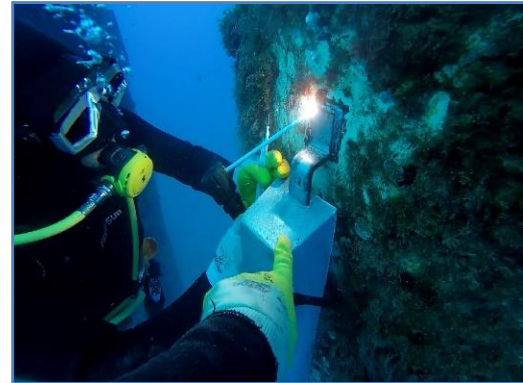
Resim 24. Çelik Ayaklara Galvanik Anot Kaynatılması
