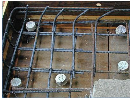
Resim 12. YUY SteelProtect Anode Montajı
