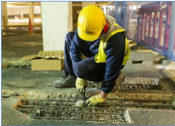
Resim 11. YUY SteelProtect Anode Montajı
