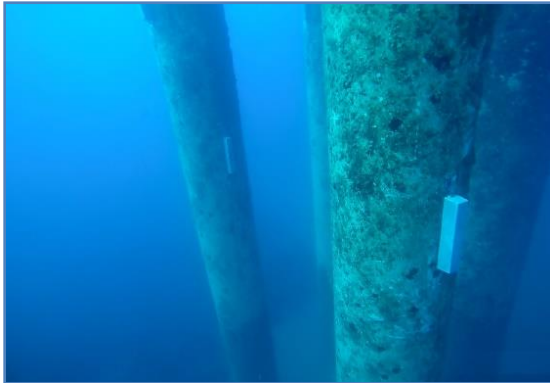
Resim 23. İskele Çelik Ayaklarına Galvanik Anot Montajı
