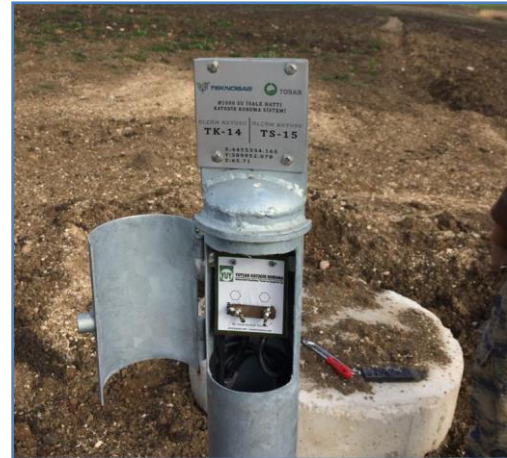
Resim 16. Boru Tipi Ölçü Kutusu Montajı
